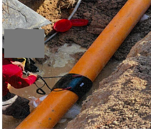
การเชื่อมต่อพลาสติก HDPE 26 มกราคม 2565 (Training on site)
