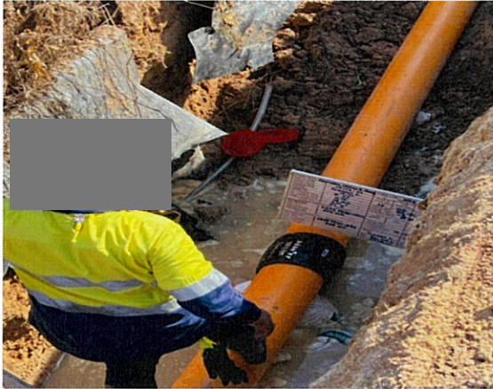
การเชื่อมต่อพลาสติก HDPE 26 มกราคม 2565 (Training on site)
